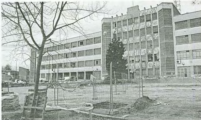
Vista de la fachada suroeste, donde se ha comenzado a construir el aparcamiento subterráneo
